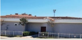
AHMET CEVDET PAŞA EĞİTİM MERKEZİ Atakent Mah. Orhan Veli Sok. No:5A Tel: 0 (216) 521 73 60
