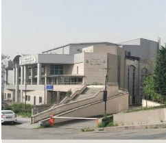
ÜMRANIYE ŞEHİT KAYMAKAM MUHAMMET FATİH SAFİTÜRK KÜLTÜR MERKEZİ Atakent, Atakent Cad. Üstündağ Sok. No:2 Tel: 0 (216) 443 56 00 ( 1137 )
