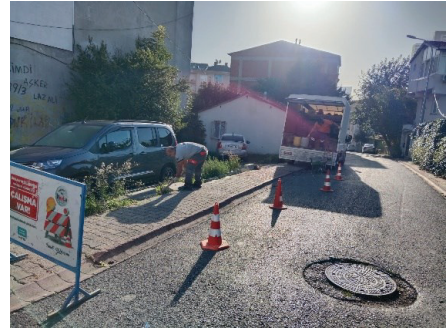
Yıllara Göre Kaldırım Onarım İmalatı
