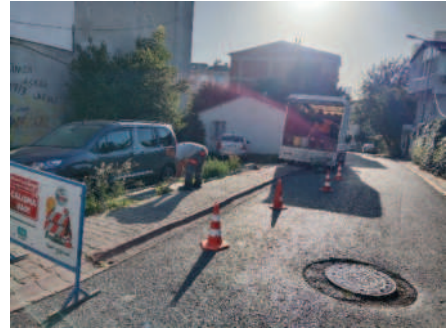
Yıllara Göre Kaldırım Onarım İmalatı
