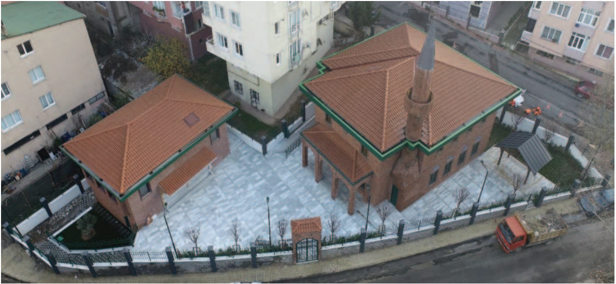
Hacı Elbeyi Coşkun Camii Çevre Düzenlemesi
