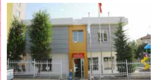
» Huzur Mahallesi Bilgi Evi
