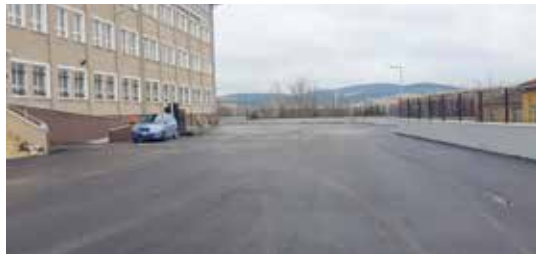
N.Fazıl Ortaokulu Asfalt Kaplama
