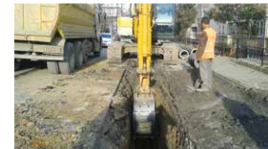
Atakent Mah. Atanur Sk. Yağmursuyu Kanal Çalışması
