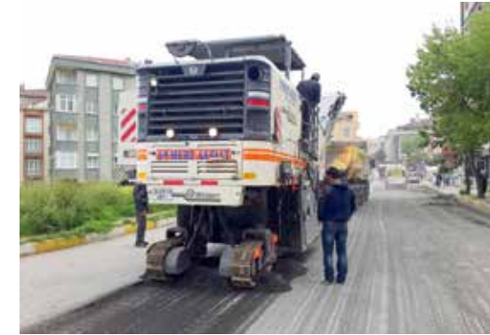
Asfalt Freze Çalışması
