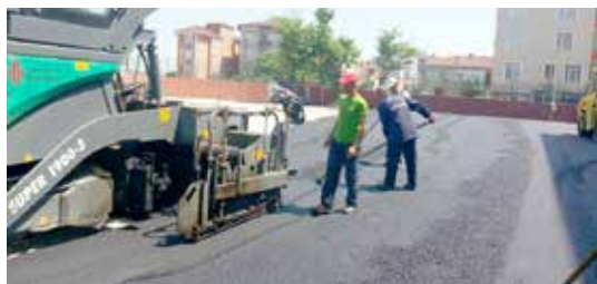
Teletaş İlkokulu Asfalt Kaplama
