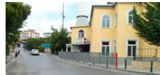
A.Dudullu Cami- Korkuluk Yapımı
