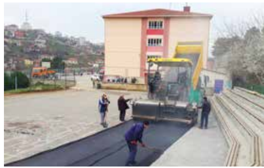
Şehit Öğretmen Ahmet Onay Ortaokulu -Asfalt Kaplama
