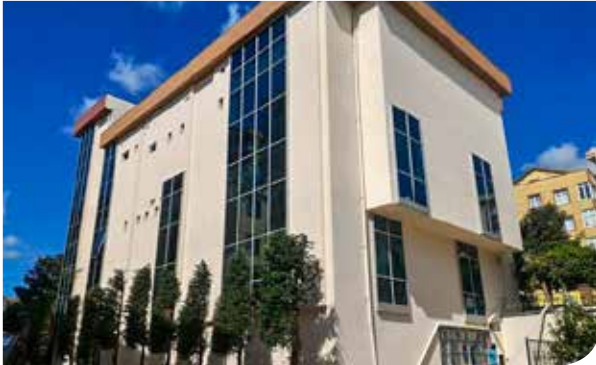
M.Akif Kültür M. Cephe Yalıtım-Boya
