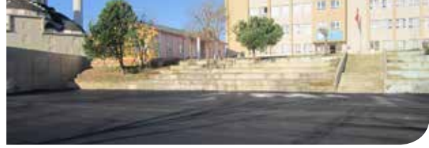
K.Karabekir Ortaokulu Asfalt Kaplama
