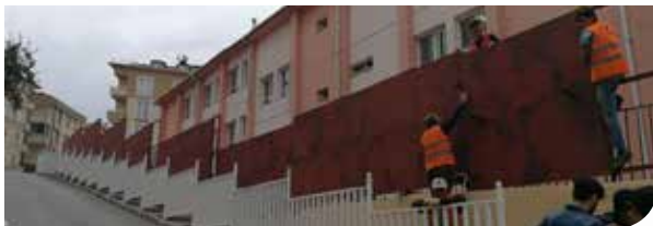
M.S.Koçak Ortaokulu Korkuluk Yapımı
