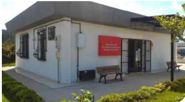
İhlamurkuyu Muhtarlık Dış Cephe Yapımı
