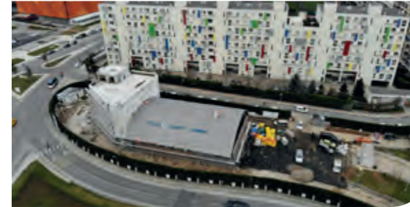
Necip Fazıl Mahallesi Yüzme Havuzu ve Spor Salonu (İnşaat Hali)
