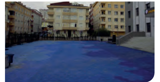
Avr.Konutları Ortaokulu-Baskı Asfalt Çalış.
