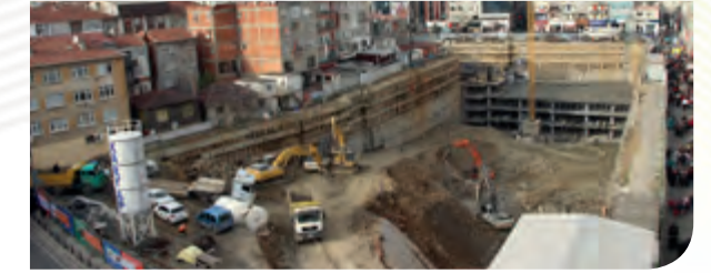
15 Temmuz Şehitler Meydanı ve Zemin Altı Katlı Otopark (İnşaat Hali)
