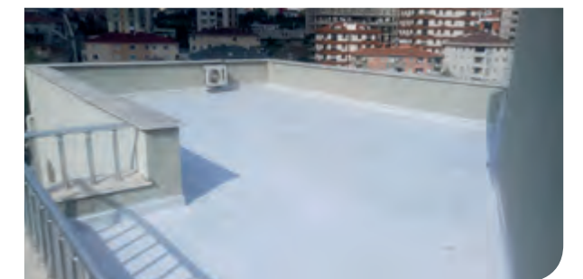
Soyak Aile Sağlığı Merkezi- Çatı İzolasyon
