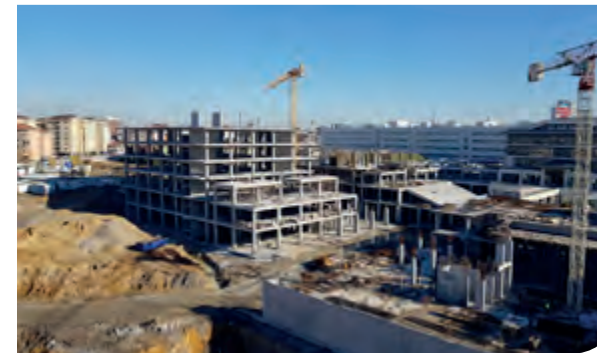
29 Mayıs Üniversitesi C Blok (İnşaat Hali)
