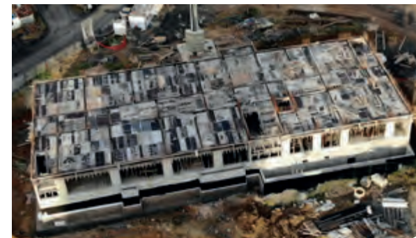
Huzur Mahallesi Can Gür İlkokulu (İnşaat Hali)
