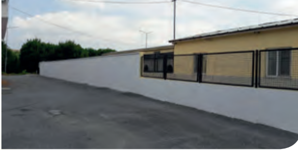
Hekimbaşı Hayvan Barınağı Tadilatı
