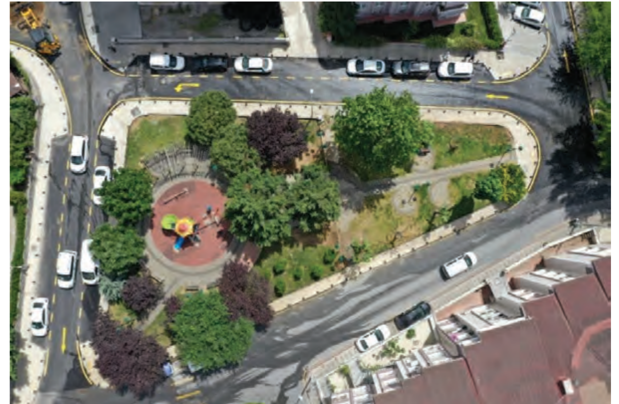
Keban Sokak Tek Yön Trafik Sirkülasyon Projesi yerinde imalat yapılarak uygulanmıştır.
