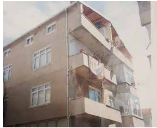
» Kentsel Yenileme Kapsamına Giren Eski Bina
