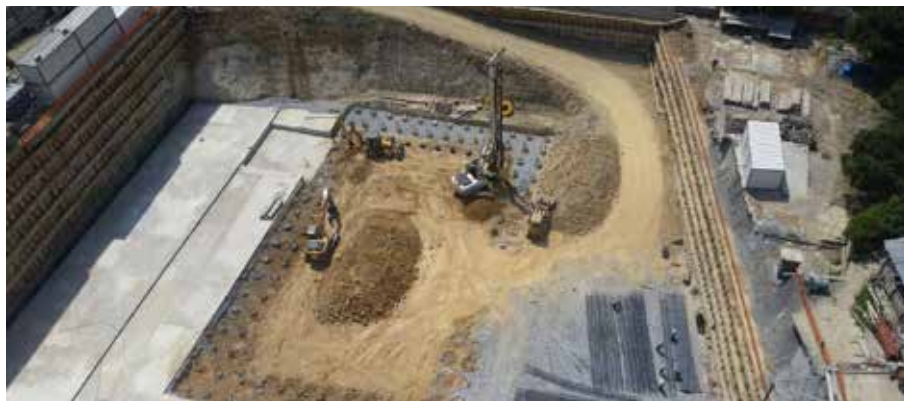
» Temel Altı Kazık ve Fore Kazık Çalışması
