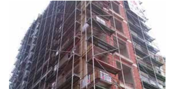
» Dış Cephe Yalıtımı
