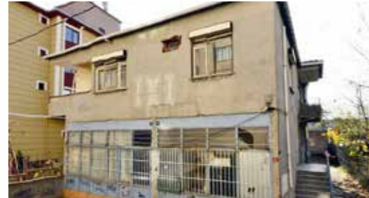
» Kentsel Yenileme Kapsamına Giren Eski Bina
