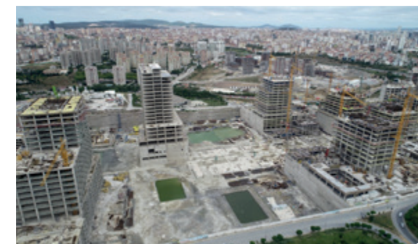
Statik Betonarme Uygulama
