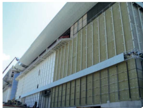
Dış Cephe Yalıtımı
