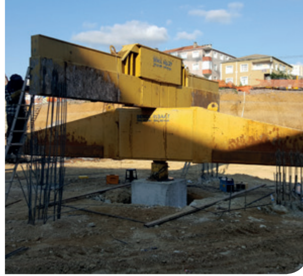
Temel Altı Kazık Çalışması
