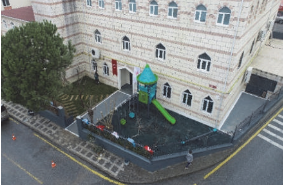
Parseller Camii Çevre Düzenleme Çalışması
