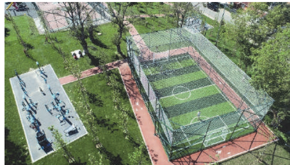
Av Köşkü Parkı Yanı Halı Saha Yapımı
