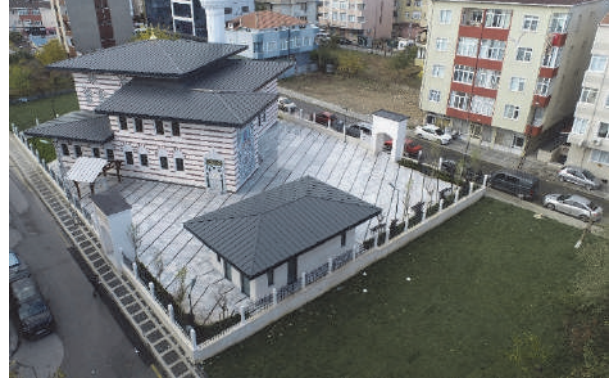
Hacı Reşit Kaki Camii Çevre Düzenleme Çalışması
