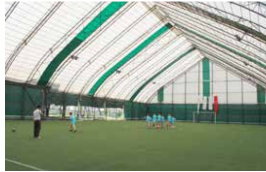
» Atakent Halı Saha Tadilatı
