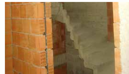
» Ara Duvar Yalıtımı
