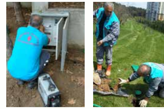
» Elektrik Tesisatı Bakım Onarımı
