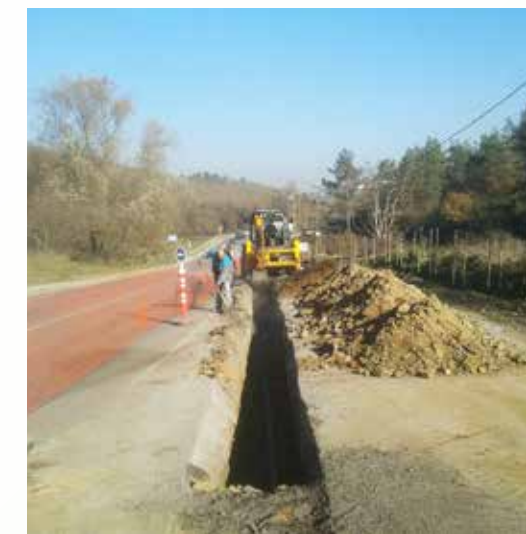
» F.S.M. Mah. Vekil Çıkmazi Kanal İmalatı
