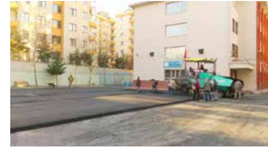
» İnkılap İlkokulu Bahçesi Asfalt Kaplama
