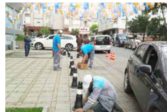
» S.Demirsoy Cd. Sınır Elemanı Onarımı
