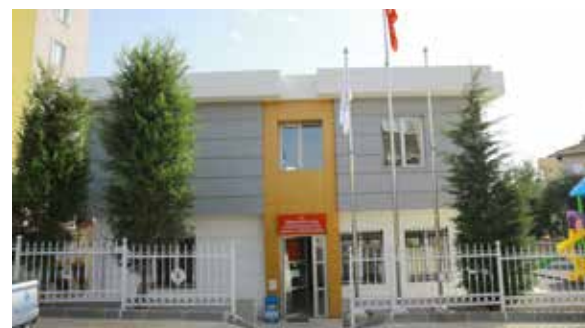
» Huzur Mahallesi Bilgi Evi
