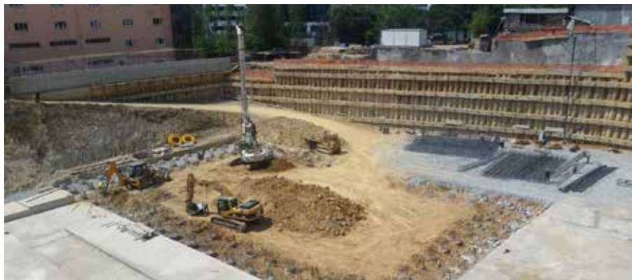
» Temel Altı Kazık ve Fore Kazık Çalışması
