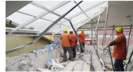
» Ruhsata Aykırı Yapı Yıkımı
