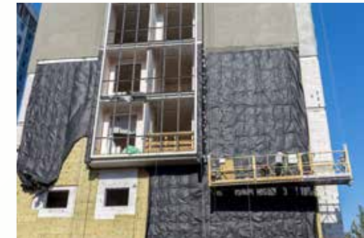
» Dış Cephe Yalıtım
