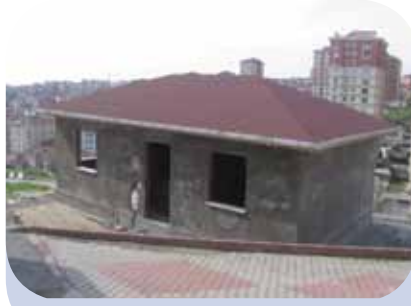
Site Muhtarlık Binası
