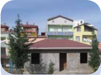
Parseller Muhtarlık Binası
