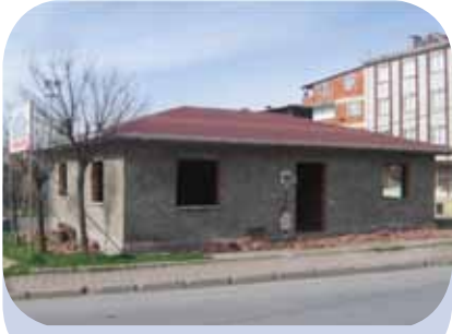
Yukarı Dudullu Muhtarlık Binası
