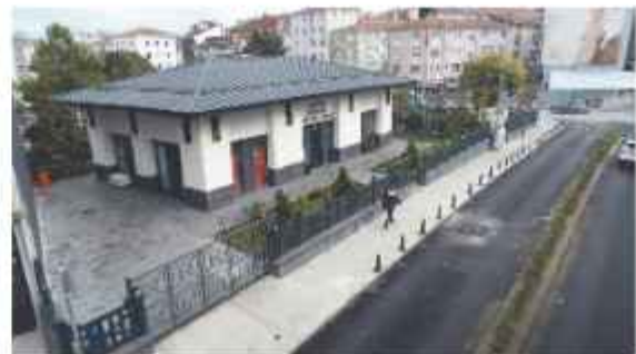
Atatürk Mahalle Muhtarlık Binası Çevre Düzenleme
