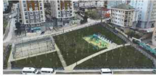
Kutlu Sokak Yeni Park Yapımı
