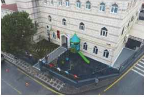
Parseller Camii Çevre Düzenleme Çalışması
