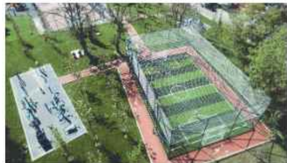
Av Köşkü Parkı Yanı Halı Saha Yapımı
