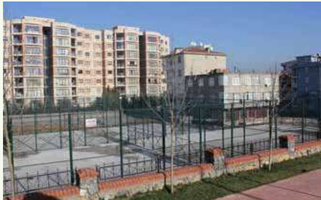
» Madenler Mahallesi-Spor Sahaları
