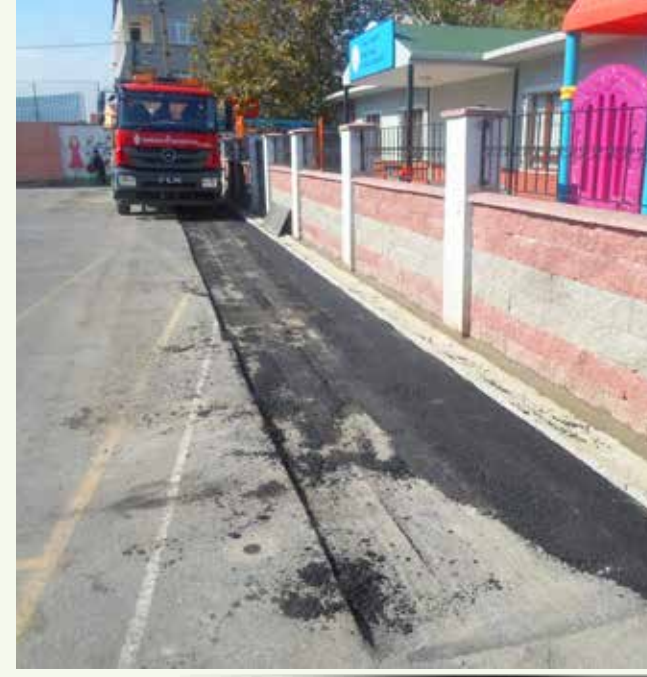
» K.Karabekir Ahmet Yavuz İ.Ö.O Asfalt Onarımı
