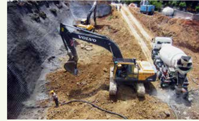
» Hafriyatta SHOT CRETE Uygulaması
