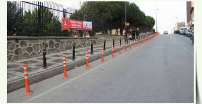
» 2013'te 1.126 adet delinatör montajı yapılmıştır.
