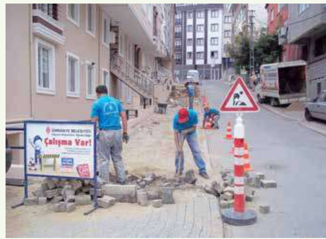
» Esenevler Mah. Umur Sokak
