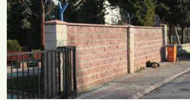
» Atakent Polis Karakolu Duvar Yapımı
