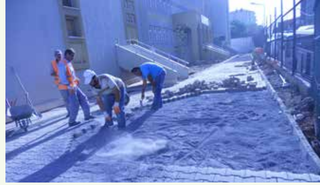
» Esenşehir Toki İ.Ö.O Kilit Taşı Bakım Onarımı
