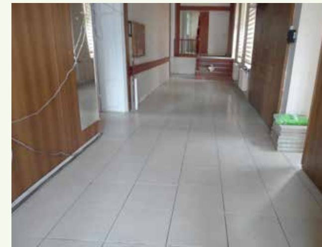
» Okulların iç mekan tadilatı
