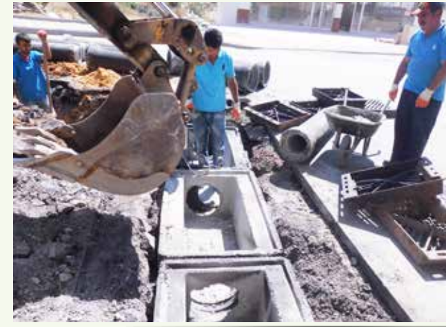
» Akdağ Caddesi Yağmursuyu Kanal Çalışması
