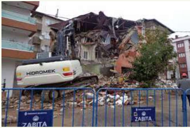
» Metruk Bina Yıkımı
