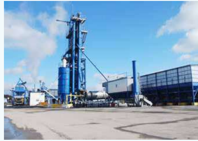
» Asfalt Üretim Tesisi
