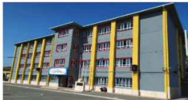
Şehit Ahmet Onay Ortaokulu Dış Cephe Boyama
