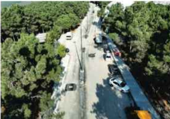
Trabzon Millet Bahçesi Yol Aydınlatma Çalışması
