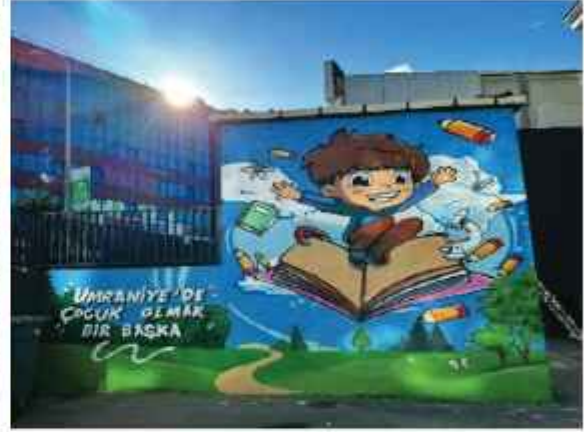
► Yamanevler Necmettin Öztürk İlkokulu Mevcut Trafo Binasi
