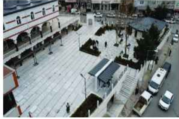
İhlamurkuyu Camii Çevre Düzenleme Çalışması
