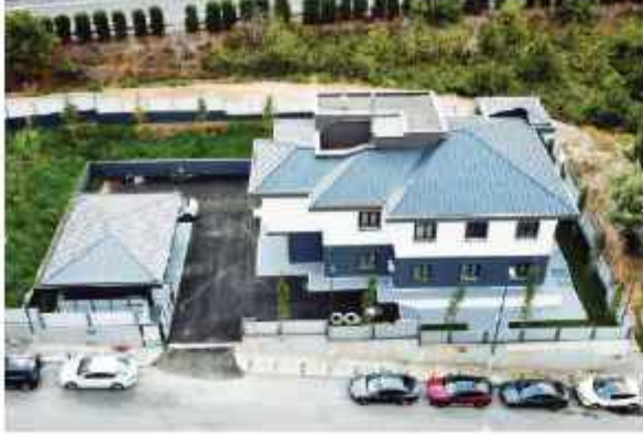
► Ümraniye Askerlik Şubesi Hizmet Binası
