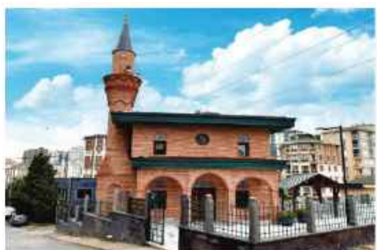
► Hoca Esman Aker Camii (Tatlısu Mahallesi)
