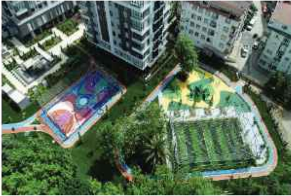
Esenevler Bölge Parkı Yeni Park Yapımı
