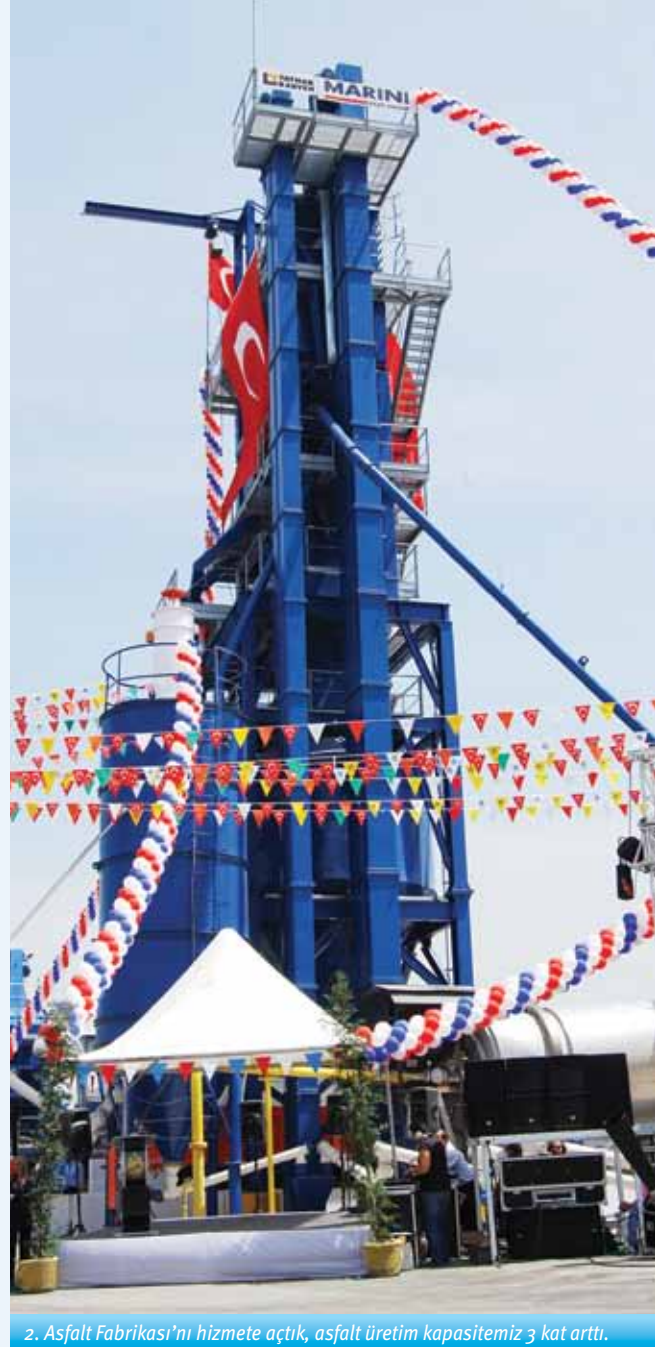
2. Asfalt Fabrikası'nı hizmete açtık, asfalt üretim kapasitemiz 3 kat arttı.
