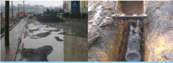
Esenşehir Mah. Kemerdere Sk. Yağmursuyu Kanalı Yapımı
