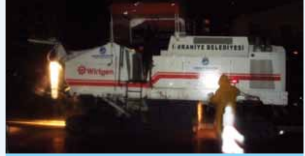
Fen İşleri Müdürlüğü, Asfalt kazıyıcı ile gece çalışması
