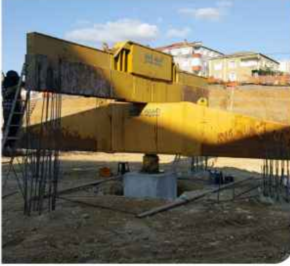
Temel Altı Kazık Çalışması
