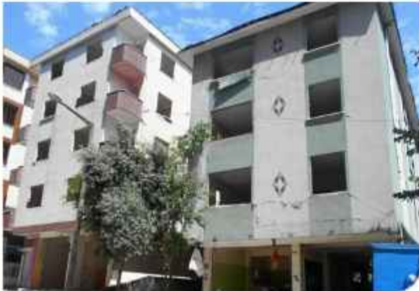
Risk oluşturan yapılar kentsel dönüşüm kapsamında yenilenmektedir.
