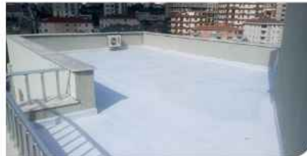
Soyak Aile Sağlığı Merkezi- Çatı İzolasyon
