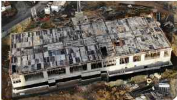
Huzur Mahallesi Can Gür İlkokulu (İnşaat Hali)
