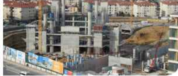
Ümraniye Büyük Camii + Zemin Altı Katlı Otopark ve Gençlik Merkezi (İnşaat Hali)
