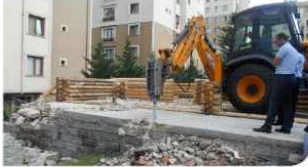
Ruhsata Aykırı Yapı Yıkımı
