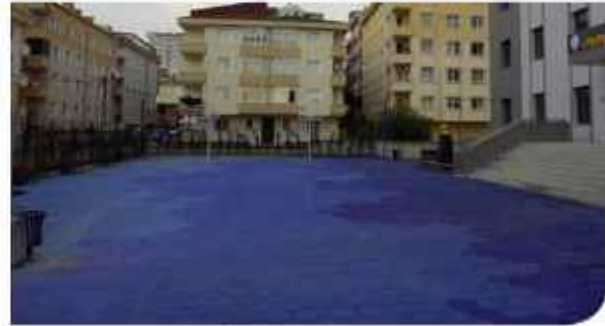
Avr.Konutları Ortaokulu-Baskı Asfalt Çalış.
