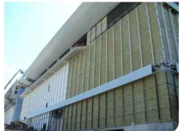
Dış Cephe Yalıtımı
