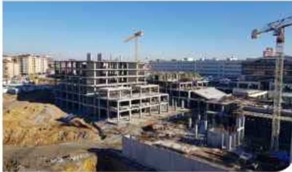
29 Mayıs Üniversitesi C Blok (İnşaat Hali)
