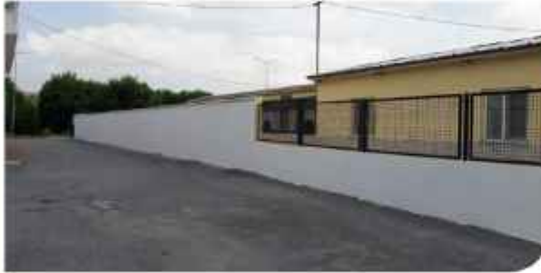
Hekimbaşı Hayvan Barınağı Tadilatı
