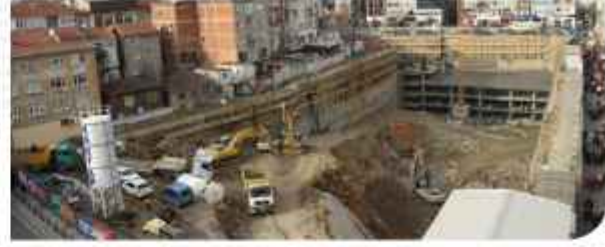
15 Temmuz Şehitler Meydanı ve Zemin Altı Katlı Otopark (İnşaat Hali)
