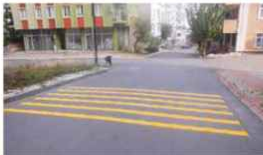
Altınşehir Mah. Akşaray Cad. Çift Kompenantlı Hız Kesici Çalışması
