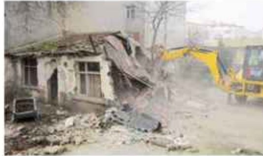
Metruk Bina Yıkımı
