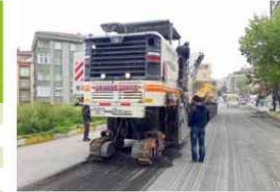
Asfalt Freze Çalışması
