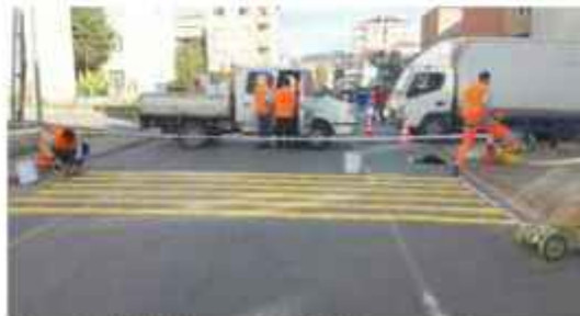
Altınşehir Mah. Akşaray Cad. Çift Kompenantlı Hız Kesici Çalışması
