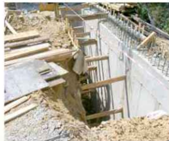
Kuyu Temel Çalışması
