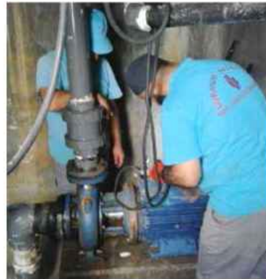
Su tesisatı onarım
