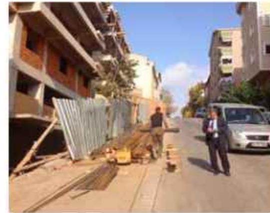
İnşaat Çalışmaları Tedbir ve Düzen Açısından Denetlenmektedir.
