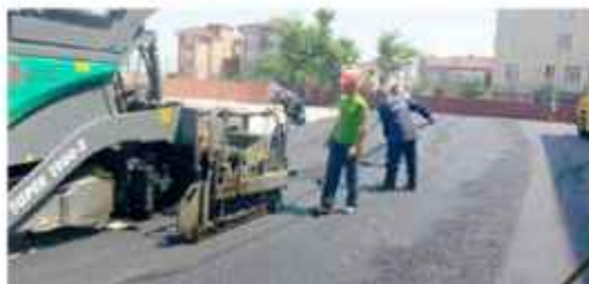
Teletaş İlkokulu Asfalt Kaplama
