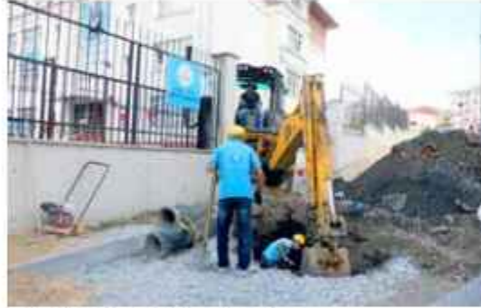
Fatih İlkokulu-Atık Su Kanalı Çalışması
