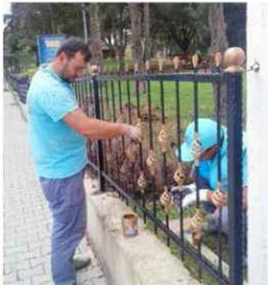
Ferforje korkuluk boyama çalışmaları
