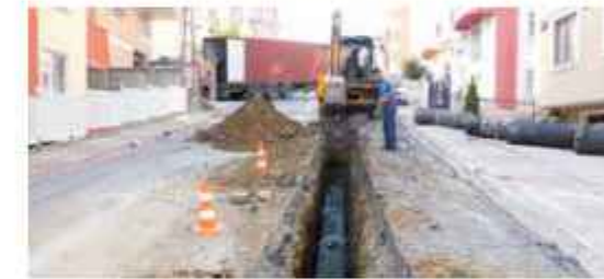
Tatlısu Mh. Şefaat Sk. Kanal İmalatı
