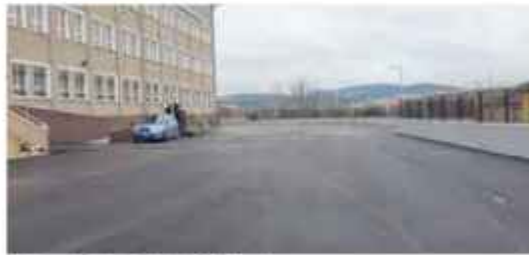
N.Fazal Ortaokulu Asfalt Kaplama
