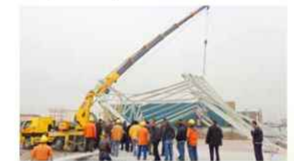
Ruhsata Aykırı Yapı Yıkımı
