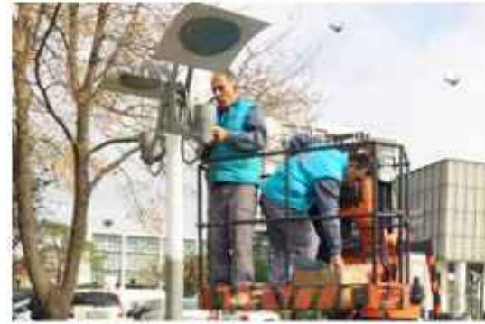
Elektrik tesisatı onarım
