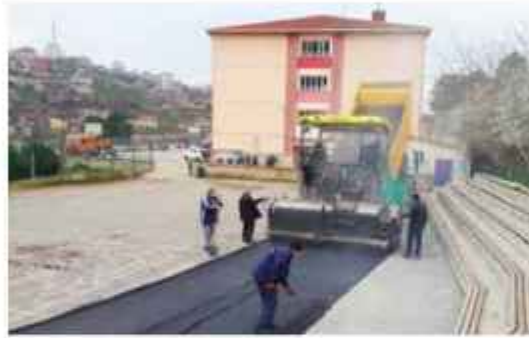
Şehit Öğretmen Ahmet Onay Ortaokulu -Asfalt Kaplama
