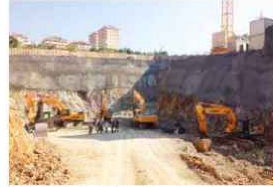
Hafriyat Kaldırılması Hafriyat Taşıma Kabul Belgesi Alınarak Yapılmaktadır.
