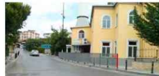
A.Dudullu Camii -Korkuluk Yapımı
