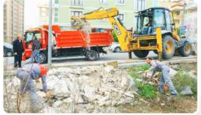
» Moloz Atıklarının İş Makinesiyle Toplanması
