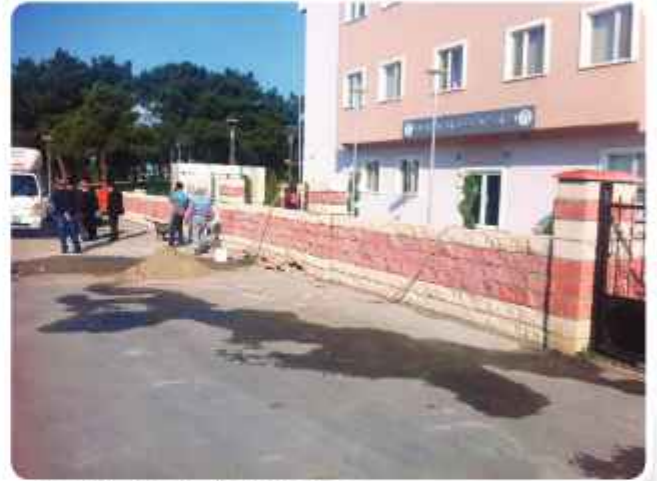
» Şule Yüksel Şenler Kız Yurdu Binası Bahçe duvarı (180 m 2 ) yapılmıştır.
