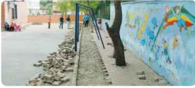
» Okul bahçelerinde yapılan kilit taşı tamiri
