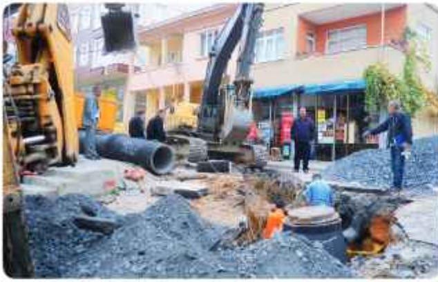
» Esenevler Mah. Akşemsettin Sokak Yağmursuyu Kanal Çalışması
