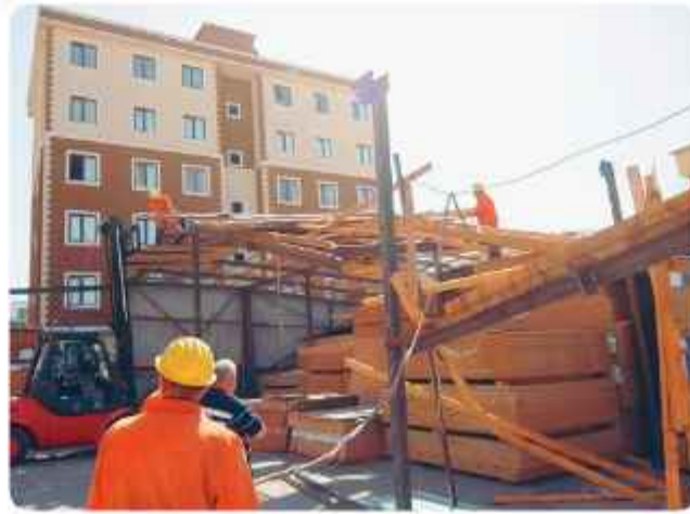
» Kaçak Yapı Yıkımı
