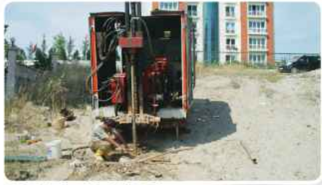
» Sondaja Dayalı Zemin Etüt Çalışması
