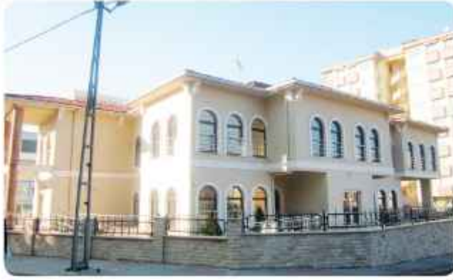
» Madenler Mahallesi Sağlık Ocağı
