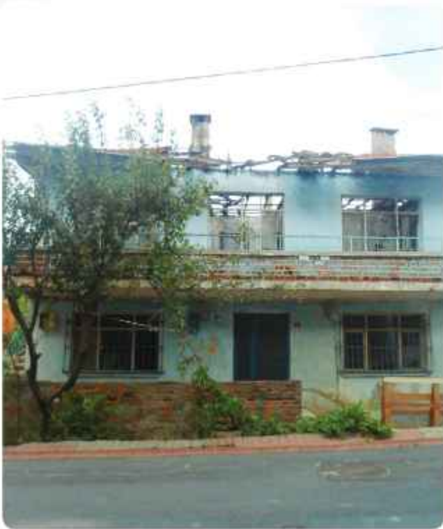
» Metruk Bina Yıkımı
