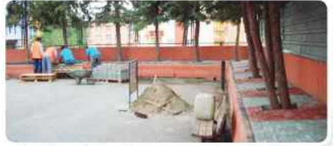
» Okul bahçelerinde yapılan bakım onarımları
