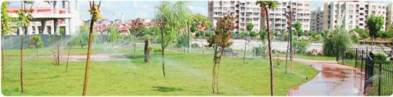
» Tüm parkların sulama tesisatı yenilenmiş, otomatik sulama sistemine geçilerek % 70 su tasarrufu sağlanmıştır.
