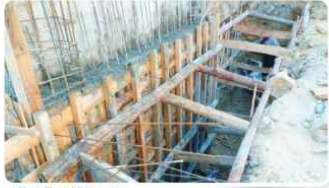
» Kuyu Temel Çalışması
