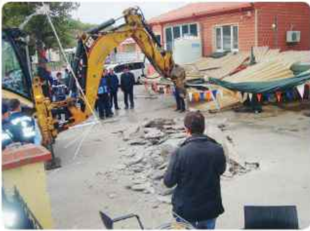
» Kaçak Yapı Yıkımı
