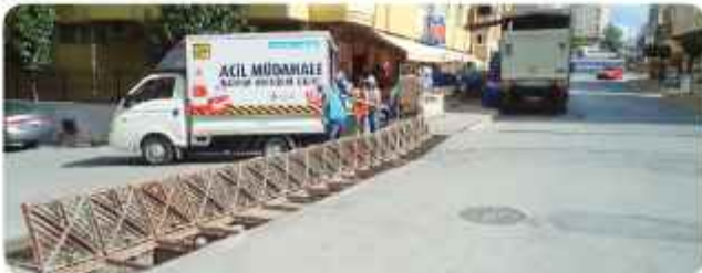
» Yağmursuyu İzgara Onarımı
