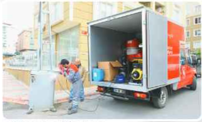
» Konteyner Tamir Bakım Onarım
