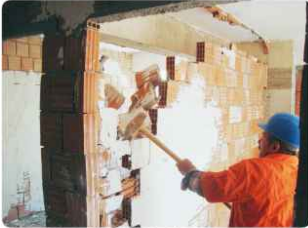
» Daireye Çevrilen Ortak Mahallerin Yıkımı
