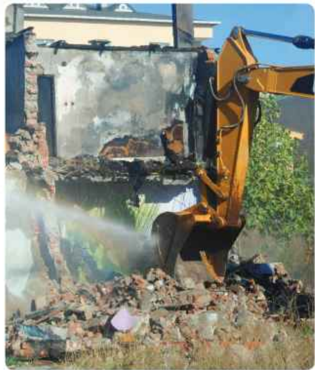
» Metruk Bina Yıkımı
