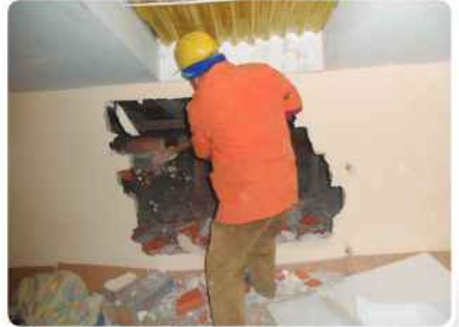
» Daireye Çevrilen Ortak Mahallerin Yıkımı
