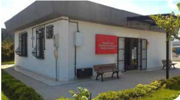
İhlamurkuyu Muhtarlık Dış Cephe Yapımı
