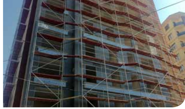
Dış Cephe Yalıtımı
