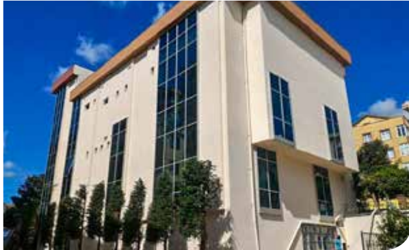
M.Akif Kültür M. Cephe Yalıtım-Boya
