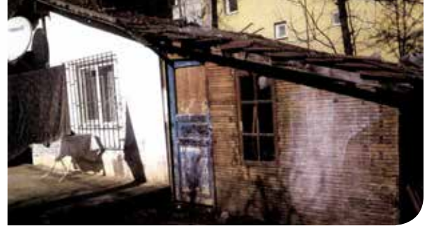
Kentsel Yenileme Kapsamına Giren Eski Bina
