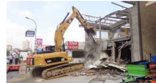
» Ruhsata Aykırı Yapı Yıkımı
