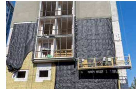
» Dış Cephe Yalıtımı
