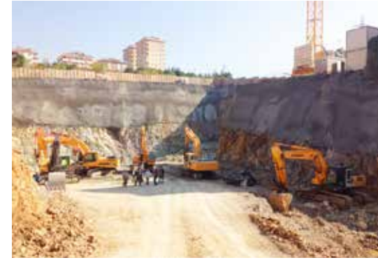
Hafriyat Kaldırılması Hafriyat Taşıma Kabul Belgesi Alınarak Yapılmaktadır.
