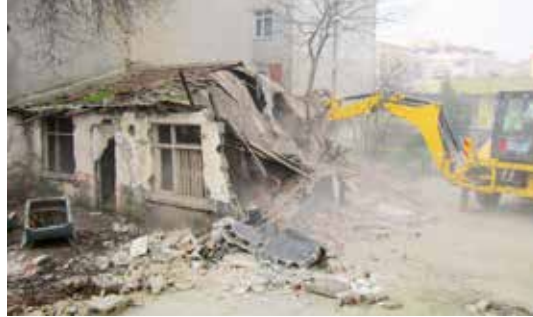
Metruk Bina Yıkımı
