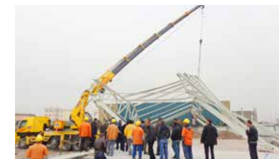
Ruhsata Aykırı Yapı Yıkımı
