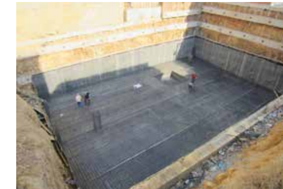
Hafriyatta SHOT CRETE Uygulaması
