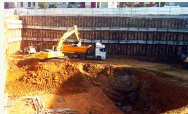
» Hafriyat Kaldırılması Hafriyat Taşıma Kabul Belgesi Alınarak Yapılmaktadır.
