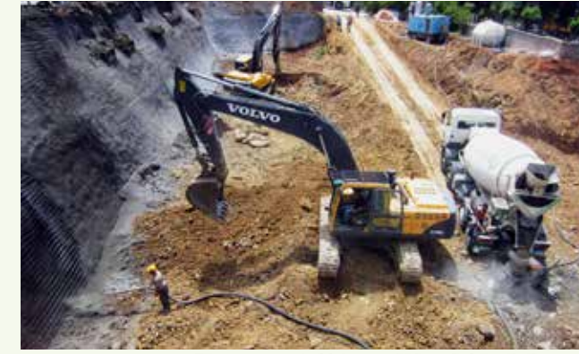
» Hafriyat SHOT CRETE Uygulaması
