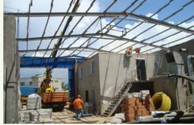
» Çelik Konstruksiyon Yıkımı
