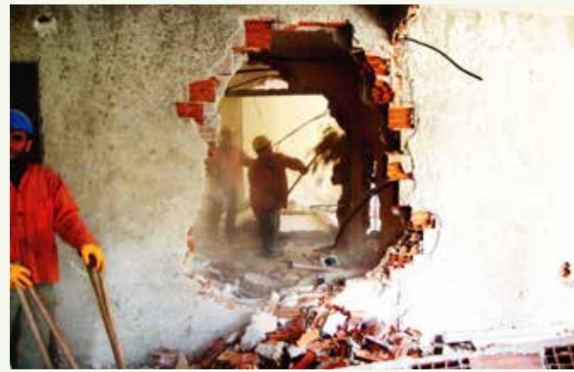
» Daireye Çevrilen Ortak Mahallerin Yıkımı
