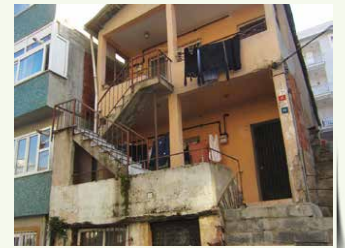
» Risk Oluşturan Yapılara Kentsel Dönüşüm Kapsamında Gerekli İşlemler Yapılmaktadır.
