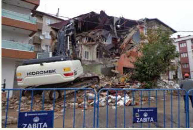
» Metruk Bina Yıkımı
