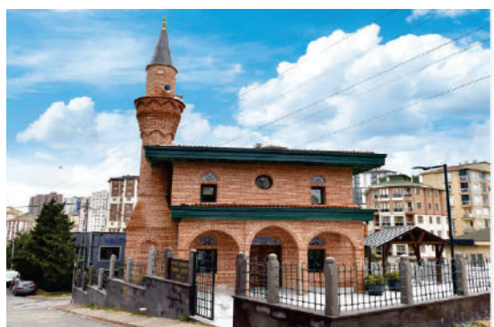
► Hoca Esman Aker Camii (Tatlısu Mahallesi)
