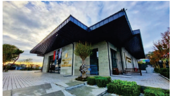
Osmangazi Millet Bahçesi Kütüphane Çevre Düzenlemesi
