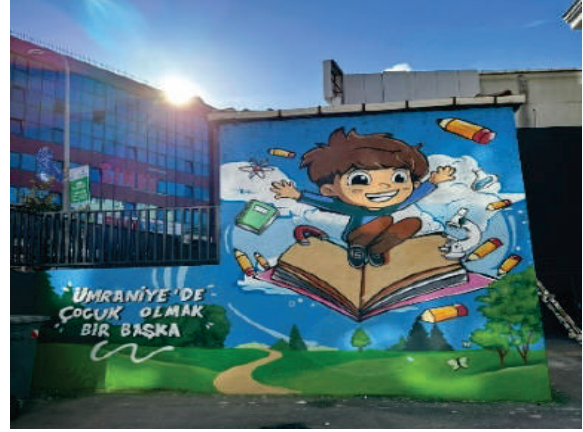
► Yamanevler Necmettin Öztürk İlkokulu Mevcut Trafo Binası
