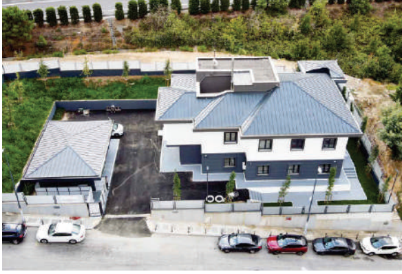
► Ümraniye Askerlik Şubesi Hizmet Binası
