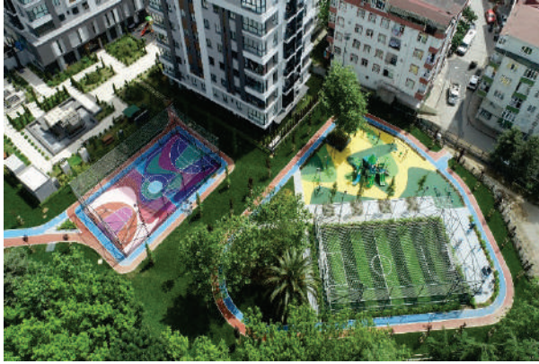
Esenevler Bölge Parkı Yeni Park Yapımı
