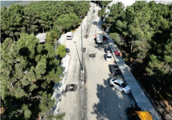
Trabzon Millet Bahçesi Yol Aydınlatma Çalışması
