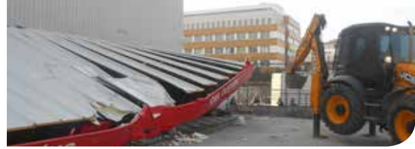
Ruhsata Aykırı Yapı Yıkımı
