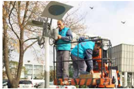
Elektrik tesisatı onarım
