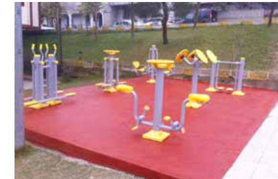
Karacaoğlan Parkı açık hava spor aleti montajı
