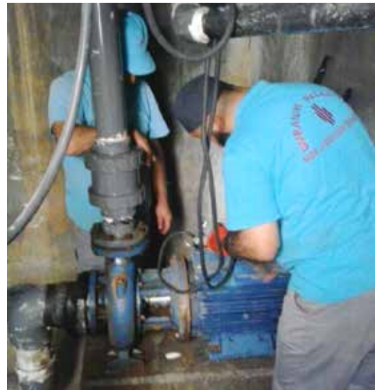
Su tesisatı onarım
