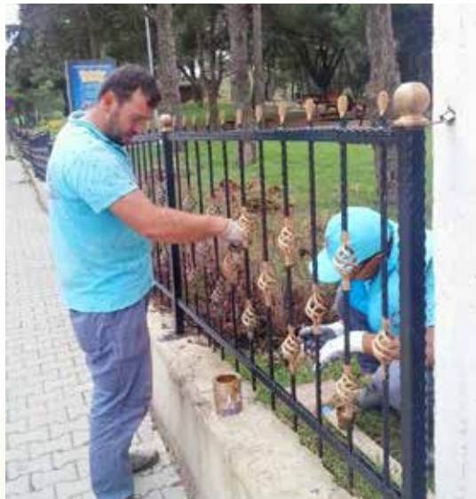
Ferforje korkuluk boyama çalışmaları
