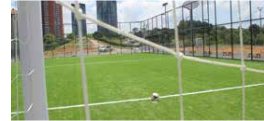
Yeşil Vadi yeni halı saha yapımı
