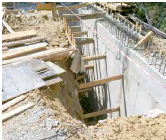
Kuyu Temel Çalışması
