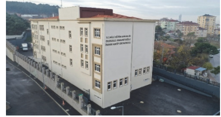
Yukan Dudullu Mahallesi Amanetoğlu İmam Hatip Ortaokulu (Tamamlandı)
