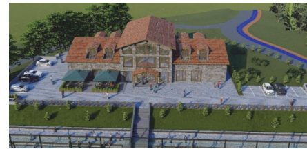
Trabzon Park Kulüp Binası (Devam Ediyor)
