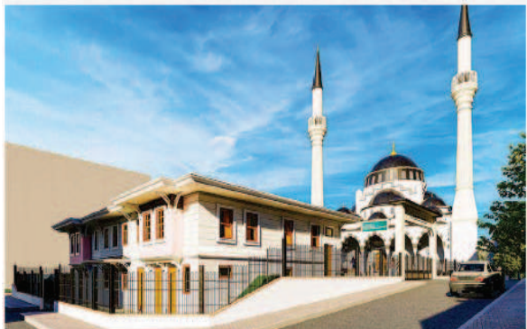
► Ömer Faruk Darende Camii (Esenkent Mahallesi)
