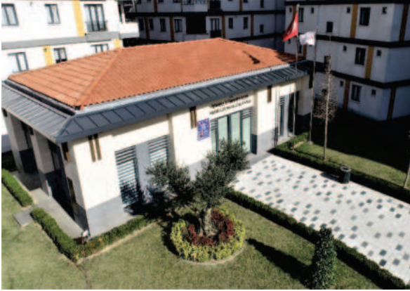
► Yamanevler Muhtarlık Hizmet Binası
