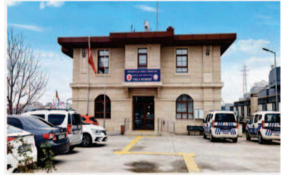
► Şehit Mücahit Ünlü Polis Merkezi (Esenkent Mahallesi)
