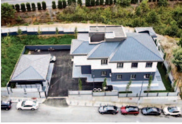
► Ümraniye Askerlik Şubesi Hizmet Binası
