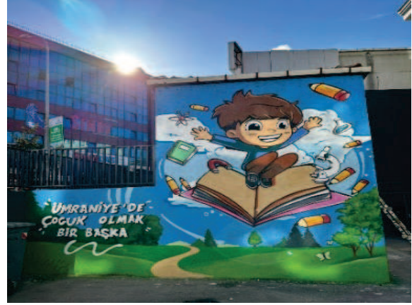
► Yamanevler Necmettin Öztürk İlkokulu Mevcut Trafo Binası
