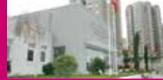
Engelliler Eğitim ve Kültür Merkezi Site Mahallesi Şenol Güneş Bulvarı No: 76 Tel: 216 533 56 56
